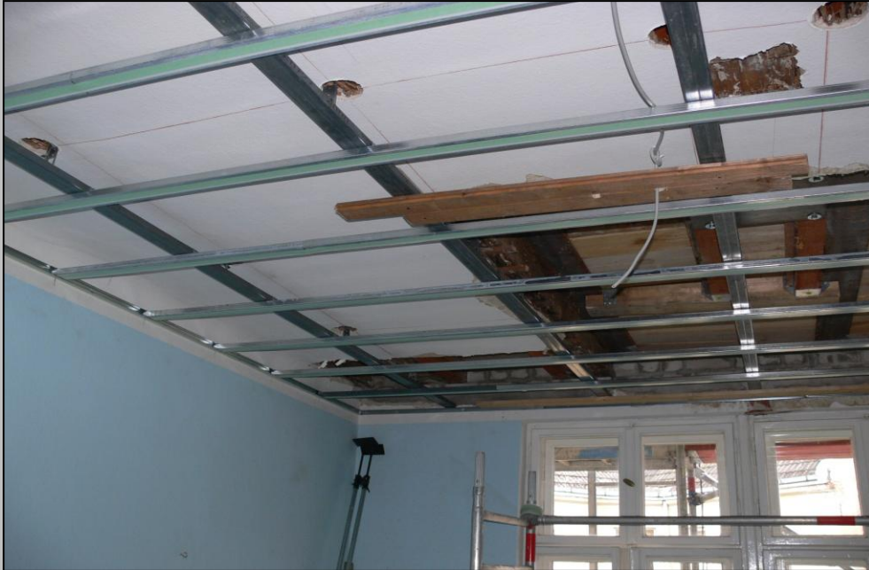
Foto 19 – Einbau einer Deckenabhängung
