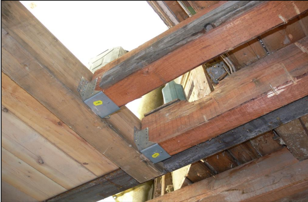
Foto 17 – Einbau neuer Hölzer nach Angabe des Statikers
