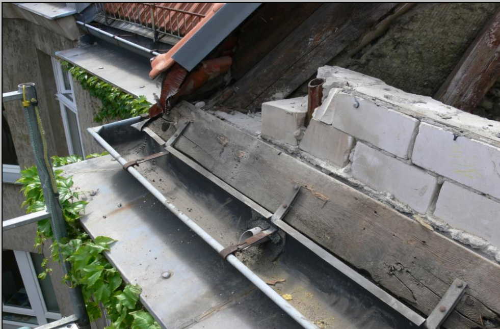
Foto 8 – Abbruch der massiven Aufkantung
