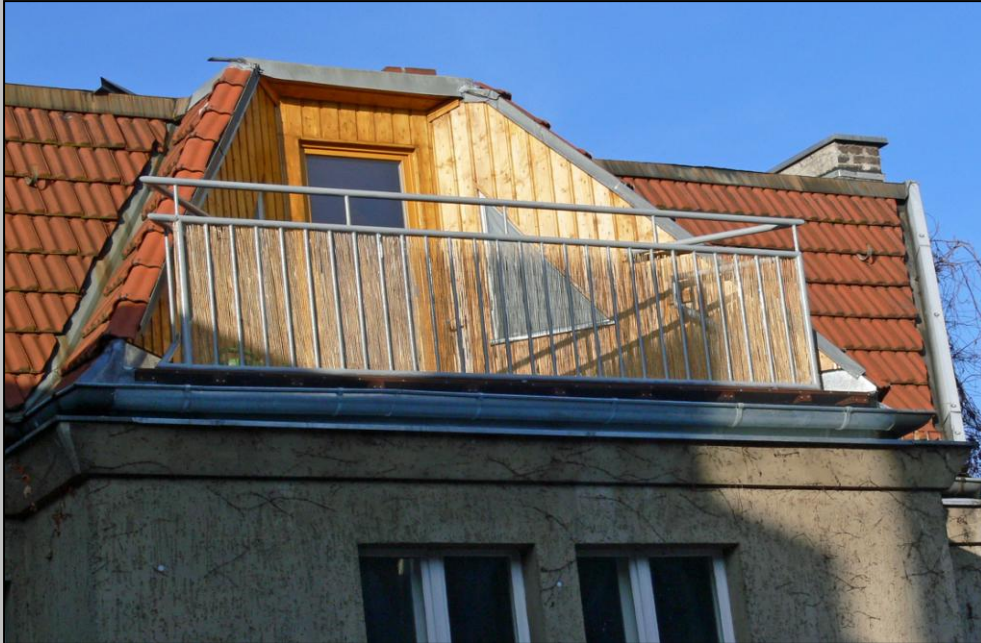
Foto 29 – Fertigstellung nach Anstrich des Geländers
