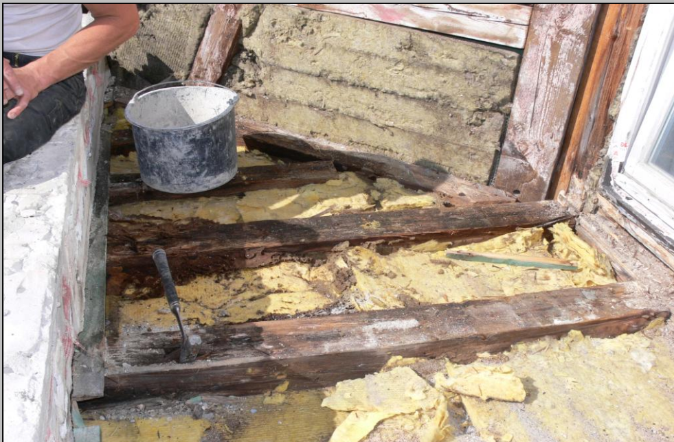
Foto 4 – nach Entfernen der Fliesen und des Estrichs
