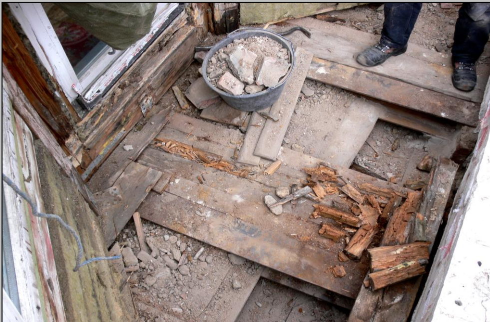
Foto 6 – Deckenkonstruktion mit schadhaften Hölzern
