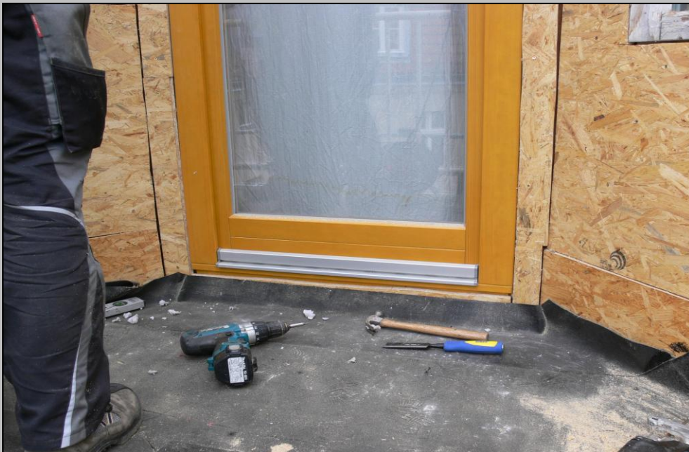
Foto 24 – Einbau der Abdichtung, Bitumenschweißbahnen
