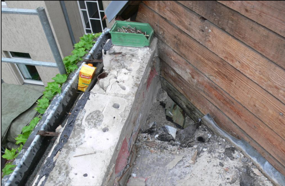
Foto 3 – Beginn der Abbrucharbeiten
