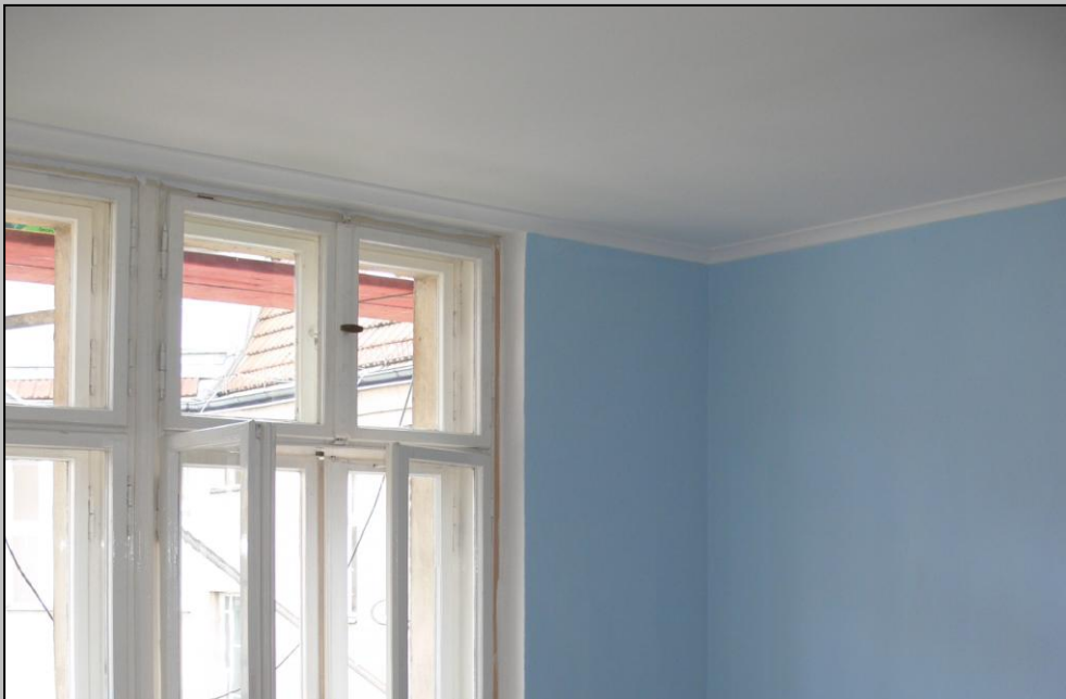
Foto 20 – Decke nach Abschluss der Sanierung
