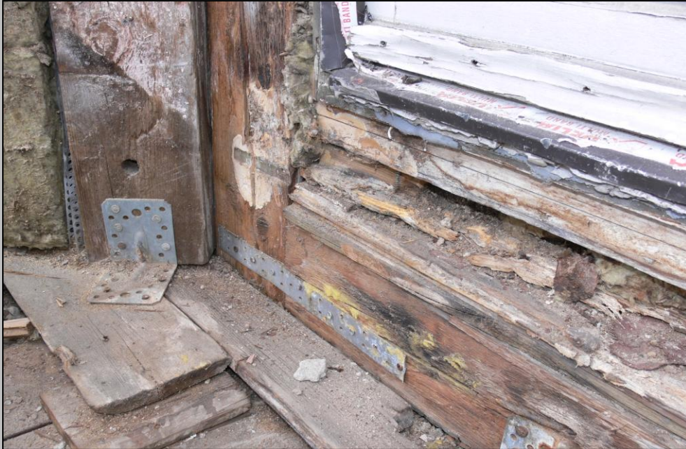
Foto 7 – von Pilzen geschädigte Türschwelle
