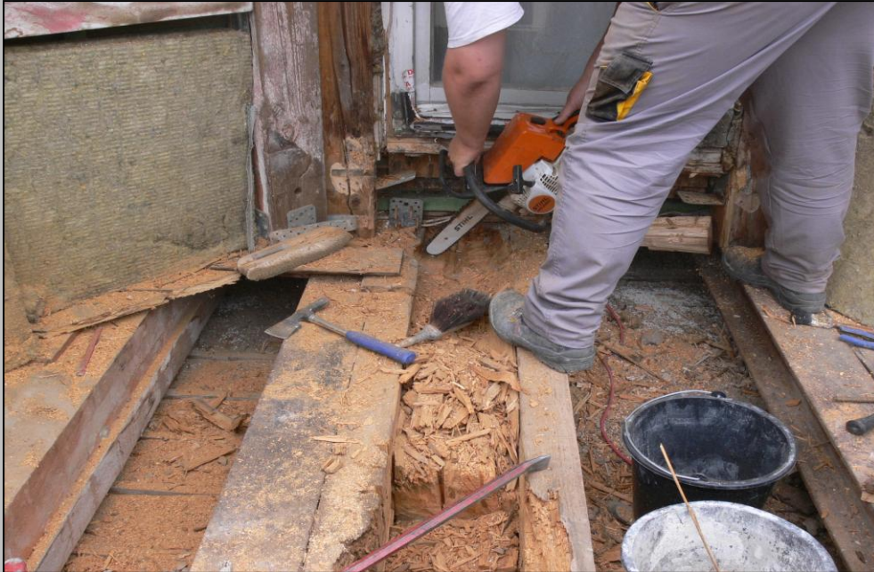
Foto 11 – Ausbau eines geschädigten Balkens
