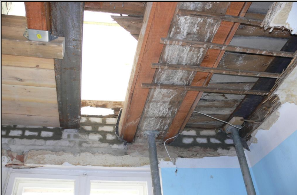
Foto 16 – Beginn der Reparatur der Holzbalkendecke
