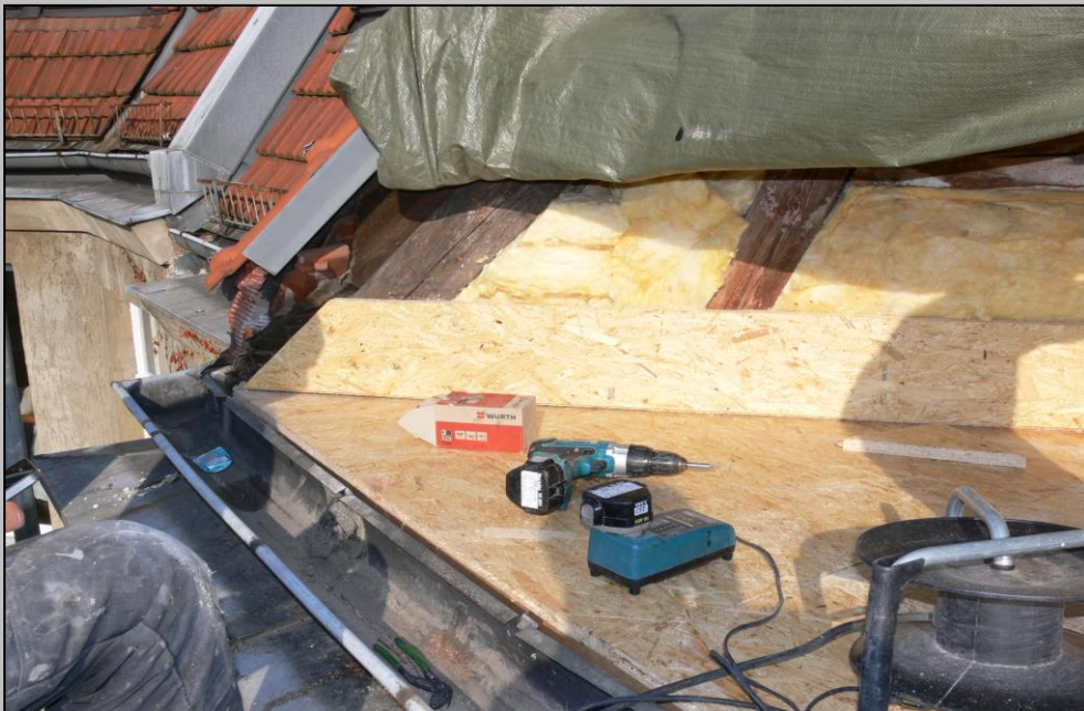
Foto 22 – Einbau von OSB-Platten
