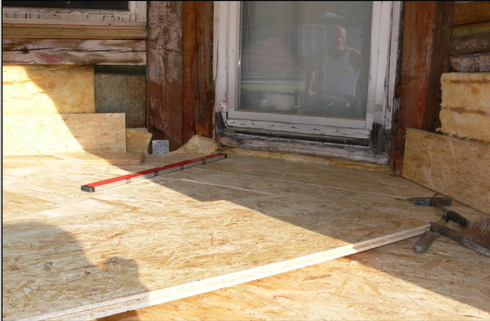
Foto 21 – Dachterrasse, Einbau von OSB-Platten
