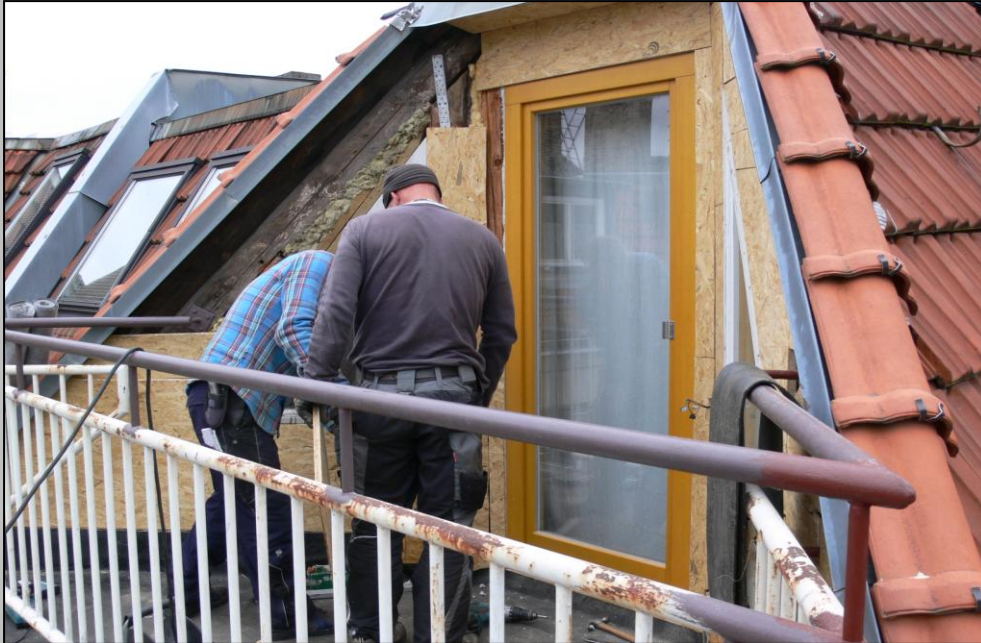
Foto 23 – Geländer nach der Erhöhung
