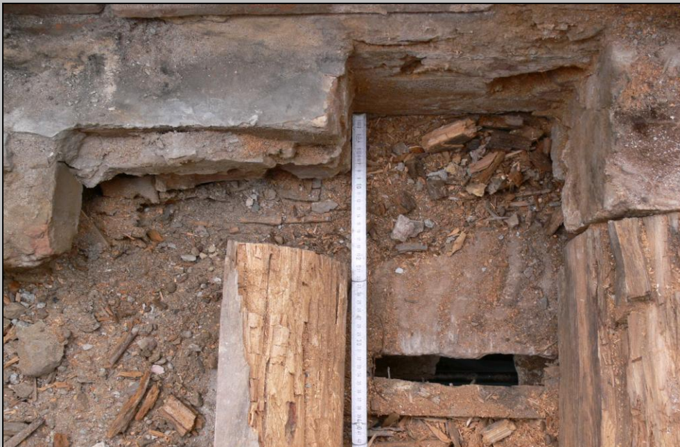
Foto 12 – freigelegtes Deckenbalkenaufleger
