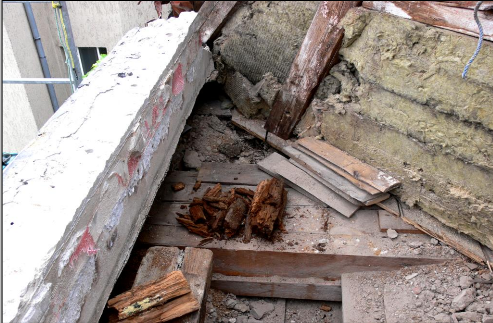
Foto 5 – Öffnung der Deckenkonstruktion
