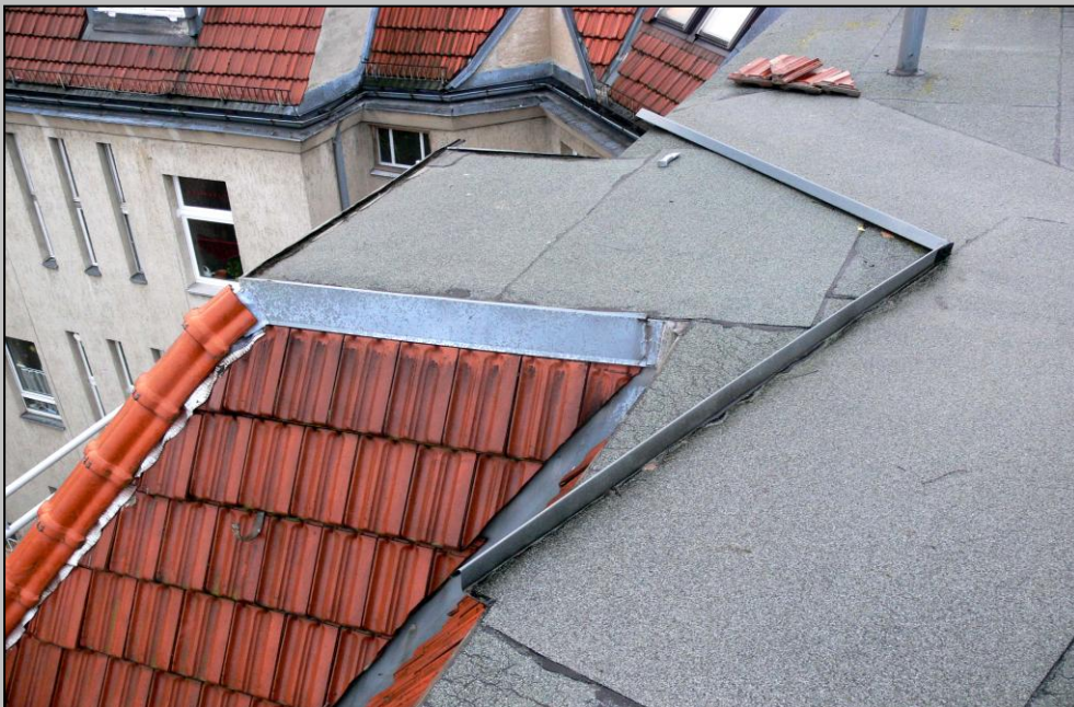
Foto 30 – Dachfläche oberhalb der Gaube
