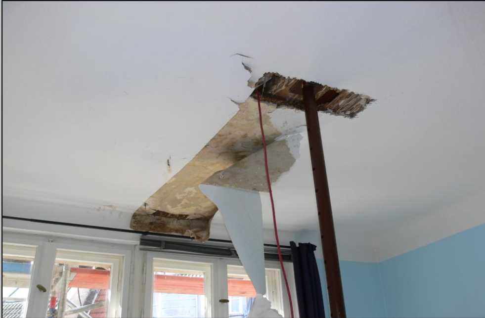
Foto 13 – Zimmerdecke unterhalb der Dachterrasse
