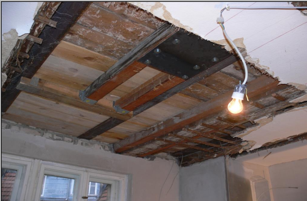
Foto 18 – Einbau einer Stahlplatte nach Angabe des Statikers
