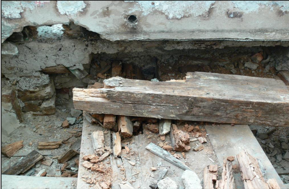
Foto 9 – von Pilzen stark geschädigte Holzteile
