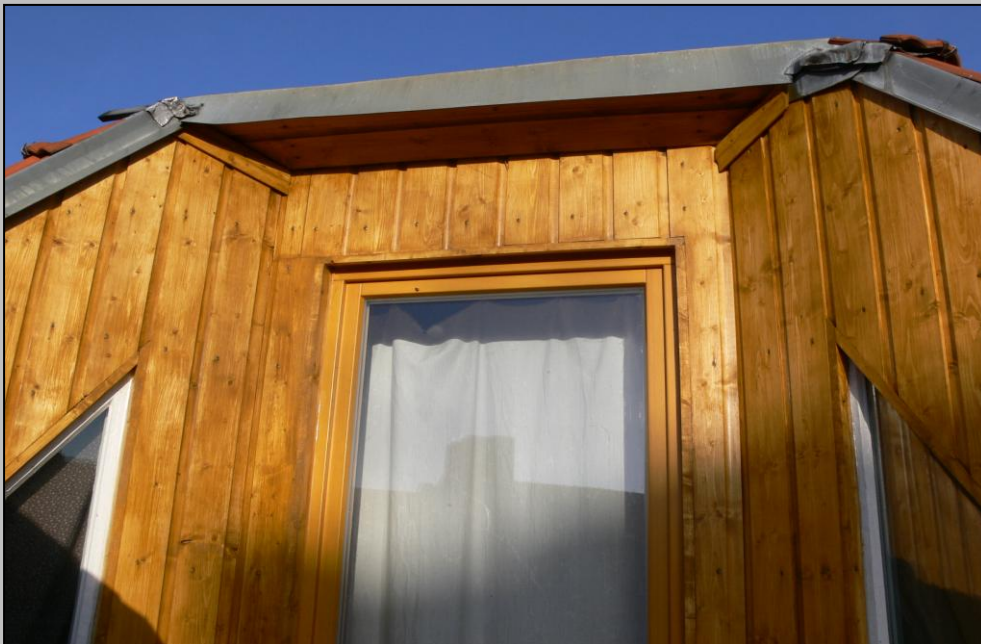
Foto 26 – neue Wandverkleidung und neue Terrassentür 19.10.2012
