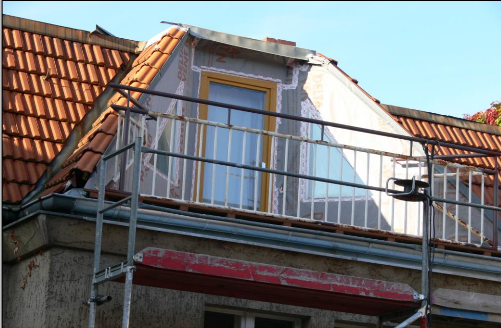
Foto 25 – Seitenwände, dampfdiffusionsoffene Unterdeckbahn 16.10.2012
